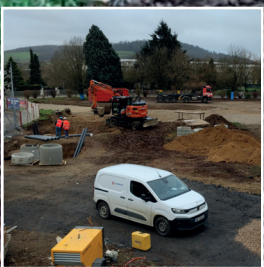
P.6 Point sur les travaux du groupe scolaire
